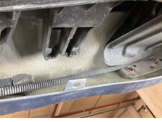
Tampon, arka, Bağlantı ayağı > Hasarlı
