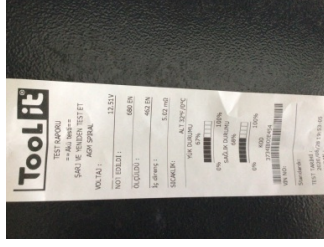
Elektrik donanımı/Pano, Akü > Test Sonucu
