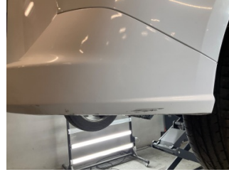
Tampon, arka, Arka tampon > Çatlak
