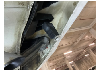
Tampon, arka, Bağlantı ayağı > Hasarlı
