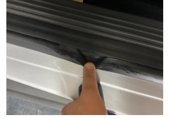
Kapı, sol ön, Kapı fitili > Hasarlı
