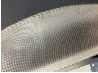
Döşemeler/Kapaklar, Döşemeler/Kapaklar > Yakıcı Madde ile Zarar Görmüş
