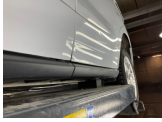
Kapı, sol arka, Kapı, sol arka > Vuruk
