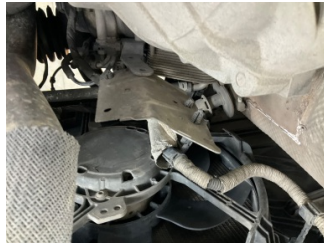
Motorsoğutması, Fan muhafazası > Kırılmış
