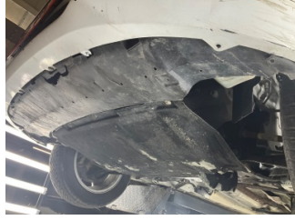
Tampon, ön, Tampon koruyucu orta > Hasarlı
