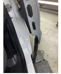
Döşemeler/Kapaklar, Döşemeler/Kapaklar > Çizik
