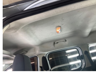
Döşemeler/Kapaklar, Döşemeler/Kapaklar > Deforme Olmuş
