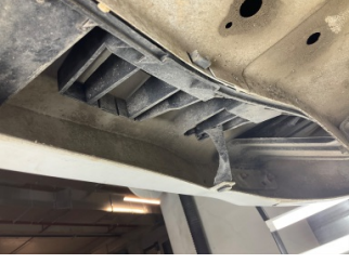
Tampon, arka, Bağlantı ayağı > Hasarlı
