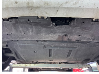
Tampon, ön, Tampon koruyucu orta > Hasarlı
