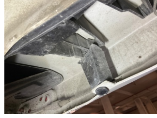
Tampon, arka, Bağlantı ayağı > Hasarlı
