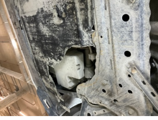
Motor, Alt muhafaza > Hasarlı
