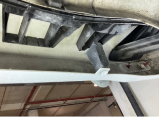
Tampon, arka, Bağlantı ayağı > Hasarlı
