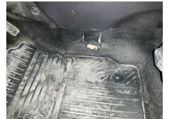
Taban, Taban halısı > Hasarlı
