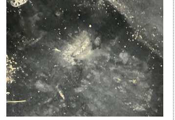
Taban, Taban halısı > Hasarlı
