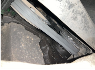
Motor, Motor > Yağ Kaçağı
