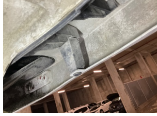
Tampon, arka, Bağlantı ayağı > Hasarlı
