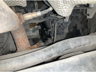
Motor, Motor > Yağ Kaçağı
