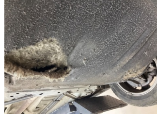
Motor, Alt muhafaza > Hasarlı
