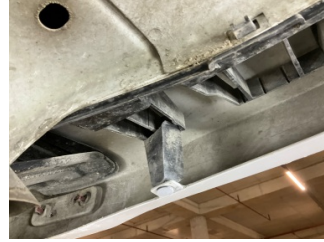
Tampon, arka, Bağlantı ayağı > Hasarlı
