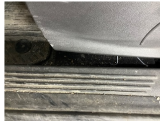
Döşemeler/Kapaklar, Döşemeler/Kapaklar > Yakıcı Madde ile Zarar Görmüş
