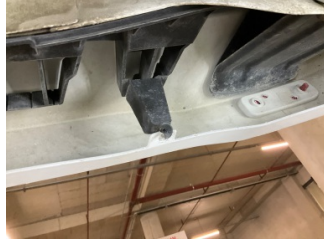
Tampon, arka, Bağlantı ayağı > Sabitlemesi Hatalı
