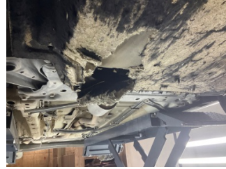
Motor, Alt muhafaza > Hasarlı
