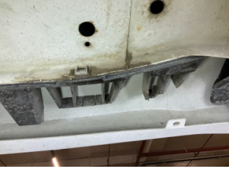
Tampon, arka, Bağlantı ayağı > Hasarlı
