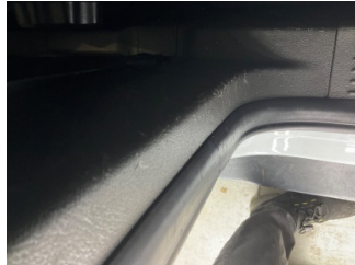
Döşemeler/Kapaklar, Döşemeler/Kapaklar > Çizik
