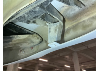
Tampon, arka, Bağlantı ayağı > Hasarlı
