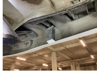
Tampon, arka, Bağlantı ayağı > Kırılmış
