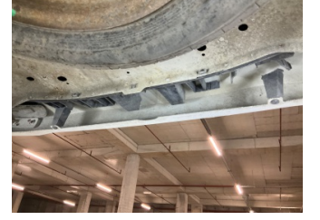
Tampon, arka, Bağlantı ayağı > Kırılmış
