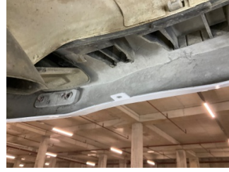
Tampon, arka, Bağlantı ayağı > Hasarlı
