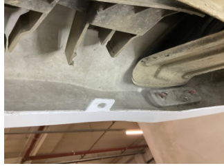
Tampon, arka, Bağlantı ayağı > Hasarlı
