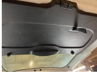
Döşemeler/Kapaklar, Döşemeler/Kapaklar > Çizik
