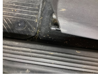
Döşemeler/Kapaklar, Döşemeler/Kapaklar > Yakıcı Madde Ile Zarar Görmüş
