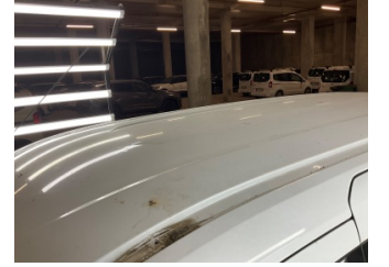
Tavan, Tavan > Dolu Hasarı
