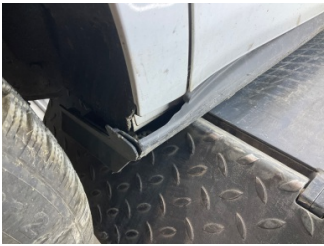
Marşbiyel, sağ, Marşbiyel plastiği, sağ > Hasarlı
