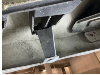
Tampon, arka, Bağlantı ayağı > Hasarlı
