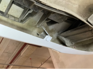
Tampon, arka, Bağlantı ayağı > Hasarlı
