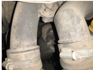
Motor, Motor > Yağ Kaçağı
