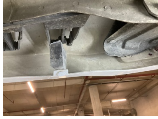
Tampon, arka, Bağlantı ayağı > Hasarlı
