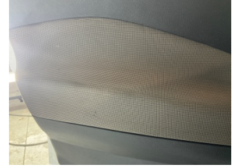
Döşemeler/Kapaklar, Döşemeler/Kapaklar > Yakıcı Madde ile Zarar Görmüş
