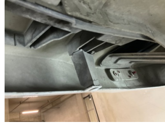
Tampon, arka, Bağlantı ayağı > Hasarlı
