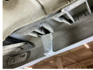
Tampon, arka, Bağlantı ayağı > Hasarlı
