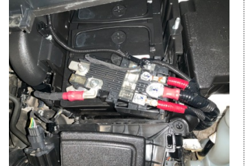
Elektrik donanımı/Pano, Akü > Onaysız
