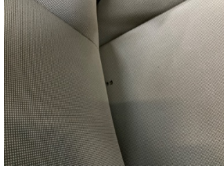
Döşemeler/Kapaklar, Döşemeler/Kapaklar > Yakıcı Madde ile Zarar Görmüş
