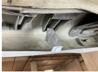
Tampon, arka, Bağlantı ayağı > Hasarlı
