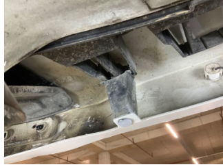
Tampon, arka, Bağlantı ayağı > Hasarlı
