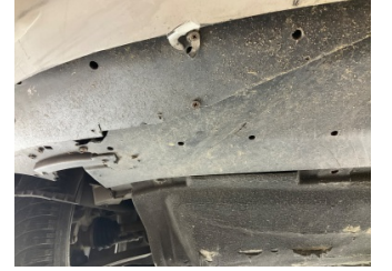
Tampon, ön, Tampon koruyucu orta > Hasarlı
