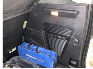
Döşemeler/Kapaklar, Bagaj bölümü döşemesi > Çizik
