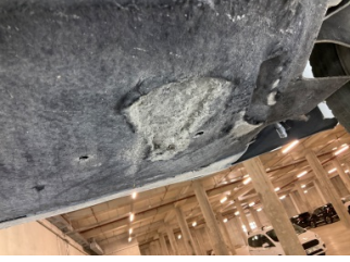
Motor, Alt muhafaza > Hasarlı
