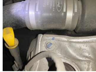
Motor, Motor > Yağ Kaçağı
