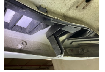
Tampon, arka, Bağlantı ayağı > Hasarlı
