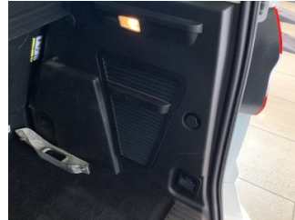
Döşemeler/Kapaklar, Bagaj kapađı, iç döşemesi > Çizik
