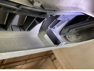
Tampon, arka, Bağlantı ayağı > Hasarlı
