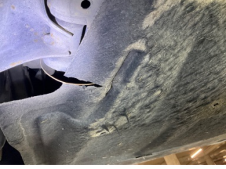
Motor, Alt muhafaza > Hasarlı
