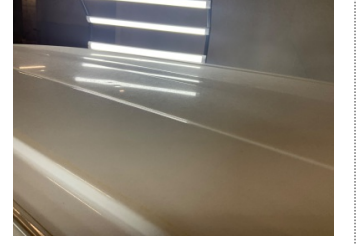
Tavan, Tavan > Dolu Hasarı
