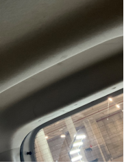
Döşemeler/Kapaklar, Döşemeler/Kapaklar > Deforme Olmuş
