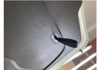
Döşemeler/Kapaklar, Döşemeler/Kapaklar > Çizik
